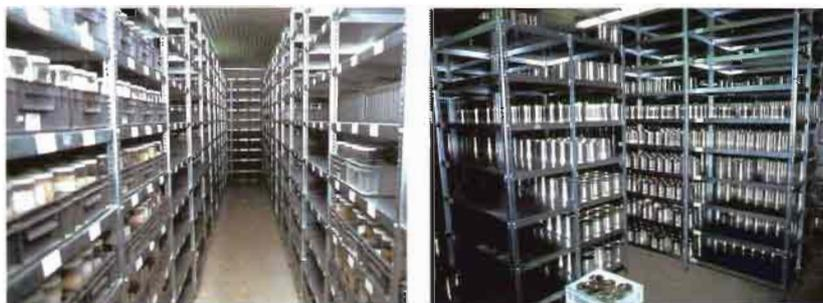
Fig. 14.- Cámaras de conservación de semillas del CRF-INIA. Las colecciones base (foto derecha) se mantienen a  $-18^{\circ}\text{C}$  y las activas (foto izquierda) a  $-4^{\circ}\text{C}$ .
